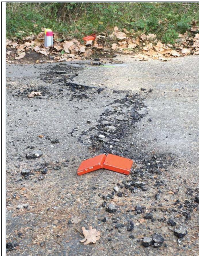
**Première observation de rupture des terrains observée le long de la discontinuité inSAR par J.F. Ritz, S. Baize, C. Larroque, M. Ferry (mission postsismique RESIF, le 13/11/2019) : bourrelets compressifs dans le goudron de la route. Petite composante senestre possible.**
