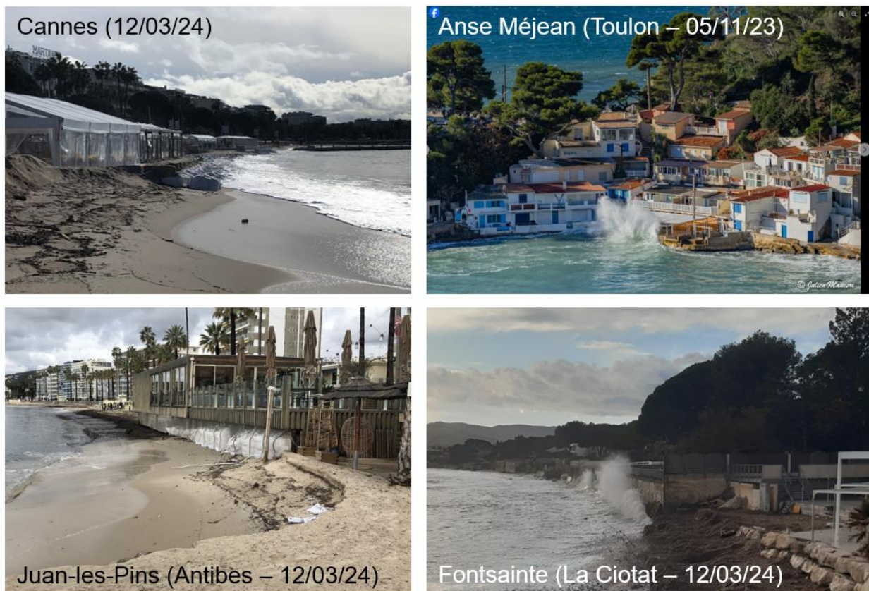
Figure 18 : exemples d'urbanisation marquée à proximité immédiate du rivage (source : Terrain BRGM et utilisateur Facebook)
