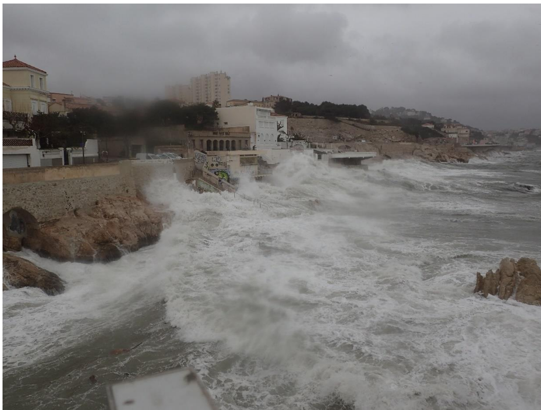
Figure 8 : coup de Mer documenté sur la Corniche à Marseille le 11 décembre 2017 (source : DDTM13)
