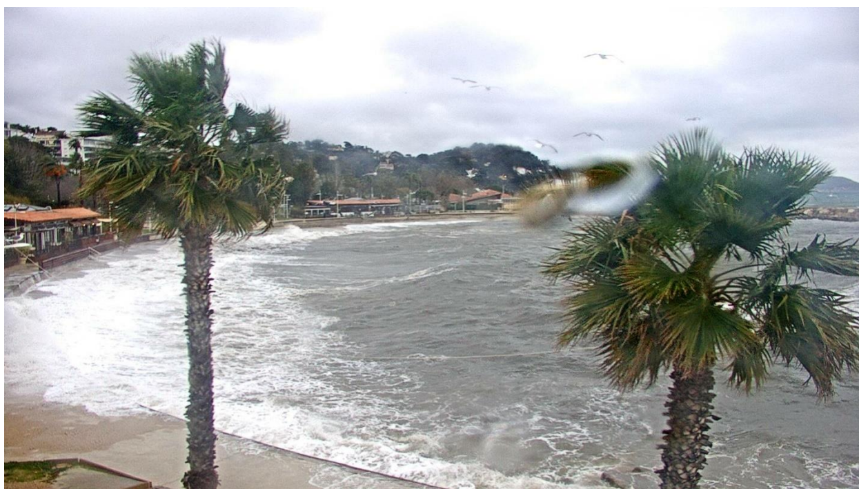
Figure 10 : submersion (franchissement par paquets de mer) observée au Mourillon lors de la tempête du 03 mars 2024 (source : Skaping)
