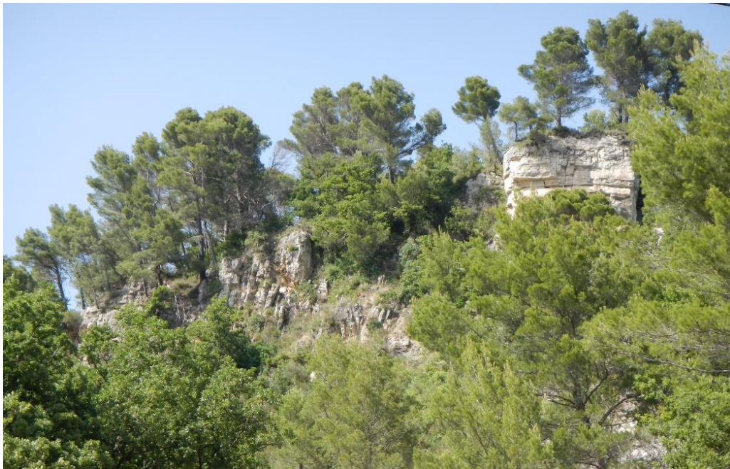
Illustration 40 : Barre dolomitique pluri métrique jaunâtre à litage net, située à une dizaine de mètres au-dessus stratigraphiquement d'un niveau de gypse exploitée artisanalement (station BAR012). À noter la fracturation subverticale très nette de direction N010-020 affectant cette barre sur la gauche de la photographie, localisation Illustration 34.
