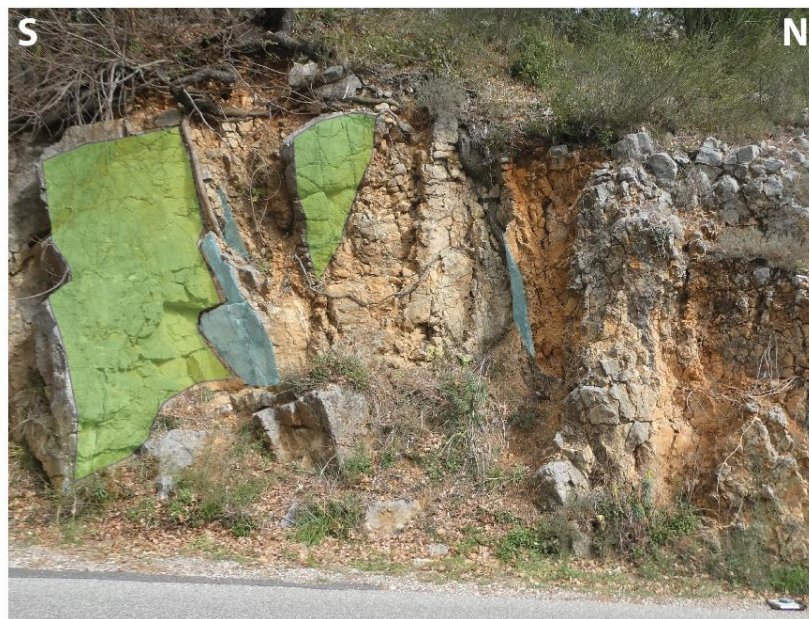
Illustration 33 : Exemple de fracturation sub-v verticale dans les calcaires du Jurassique (2 plans de fracturation en vert et bleu), BAR105, localisation Illustration 29.
