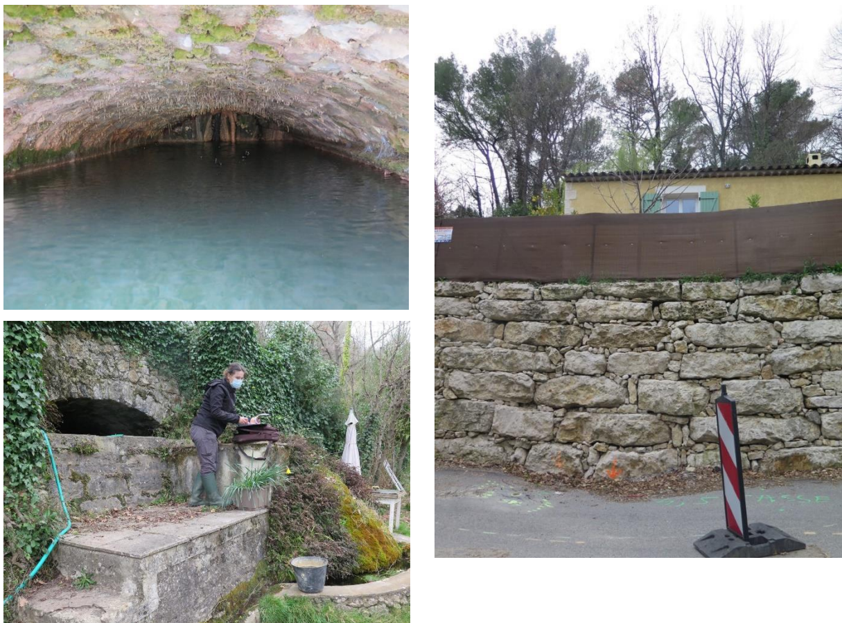
Illustration 74 : Photographies de la source Ste Bibiane (à gauche) et du mur de soutènement de la propriété au 463 rue Jean Jaurès au pied duquel se situe le piézomètre "Froute". L'affaissement de la route est visible sur la photo (marqué par la flèche orange).
